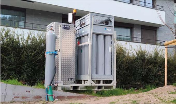
*Fabrication spéciale: châssis hélicoptère avec système de neutralisation automatique. Espace pour un cadre de bouteilles ou des bouteilles individuelles.*
